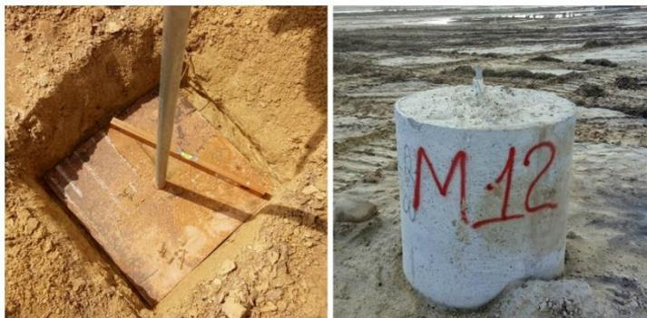
Figura 8 -a) Instalação de placas de recalque nivelada em contato com solo natural; b) conservação das hastes de alteamento das placas com manilhas de concreto para proteção de eventuais impactos de equipamentos de obra
